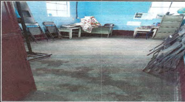
Foto1: SUSTITUSION DE TORTA DE CEMENTO POR PISO DE GRANITO DE LA DIRECCIÓN
