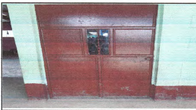
Foto 10: ARREGLO DE PUERTA DE PREPRIMARIA SECCION A
