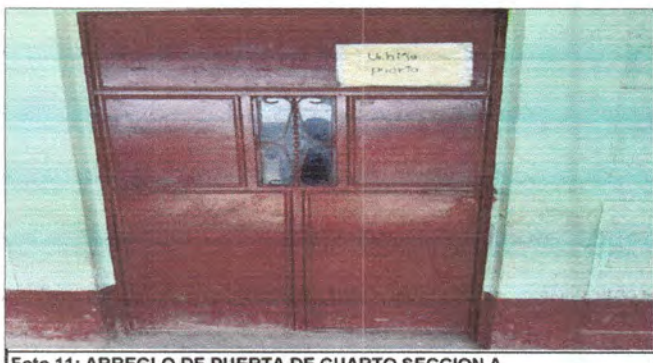
Foto 11: ARREGLO DE PUERTA DE CUARTO SECCION A
