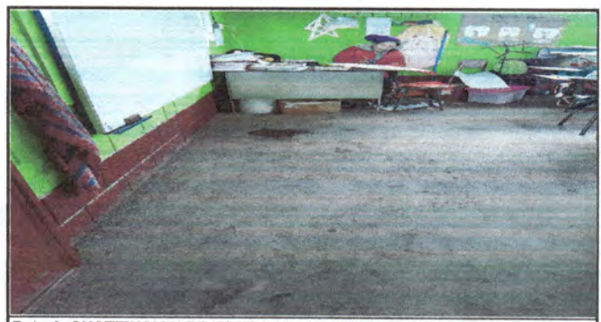
Foto 6: SUSTITUSION DE TORTA DE CEMENTO POR PISO DE GRANITO DE CUARTO SECCION A
