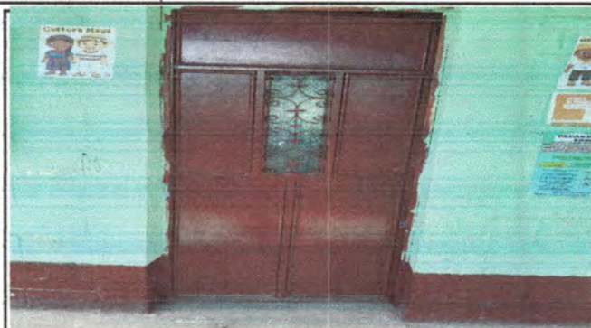
Foto 7: ARREGLO DE PUERTA DE LA DIRECCIÓN
