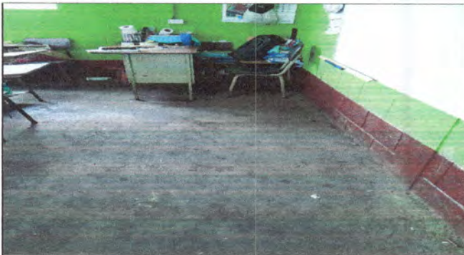
Foto3: SUSTITUSION DE TORTA DE CEMENTO POR PISO DE GRANITO DE SEGUNDO SECCION A
