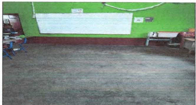
Foto 4: SUSTITUSION DE TORTA DE CEMENTO POR PISO DE GRANITO DE SEXTO SECCION A
