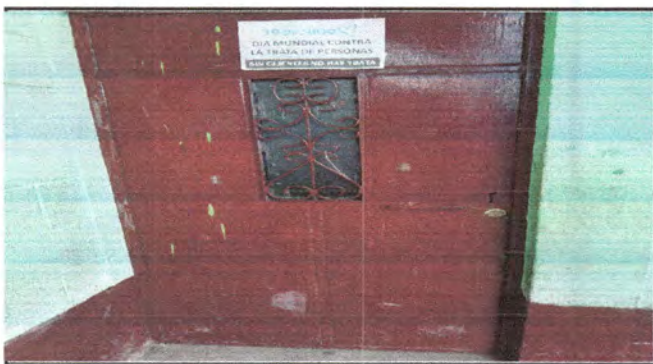
Foto 9: ARREGLO DE PUERTA DE QUINTO SECCION A
