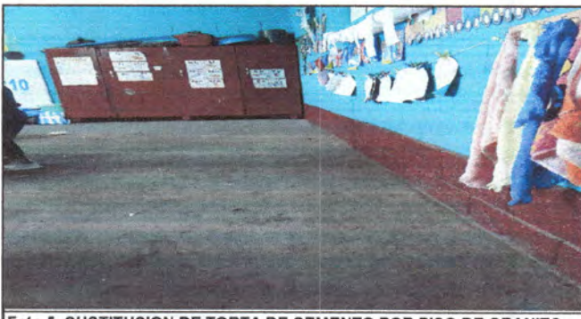
Foto 5: SUSTITUSION DE TORTA DE CEMENTO POR PISO DE GRANITO DE PREPRIMARIA SECCION A
