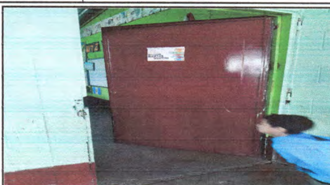
Foto 8: ARREGLO DE PUERTA DE PRIMERO SECCIÓN A
