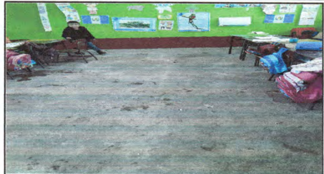
Foto2: SUSTITUSION DE TORTA DE CEMENTO POR PISO DE GRANITO DE PREPRIMARIA SECCION B
