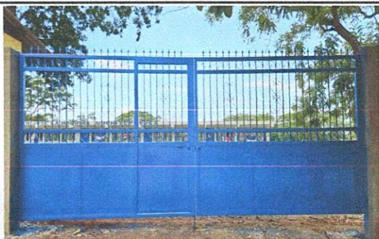
Foto 5: Suministro e instalación de portón de metal, de 6 m de largo, por 2.5 m de alto, pintado de color azul
