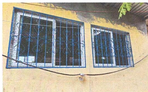
Foto 4: Suministro e instalación de ventanas de PVC.
