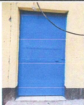
Foto 3: Mantenimiento a puerta de acceso a la cocina, lijado, cepillado y aplicación de pintura anticorrosiva de color azul.
