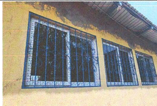
Foto 2: Mantenimiento a balcones de metal, lijado, cepillado y aplicación de pintura anticorrosiva de color azul.
