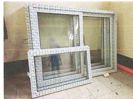
Foto 4: Suministro e instalación de ventanas de PVC.
