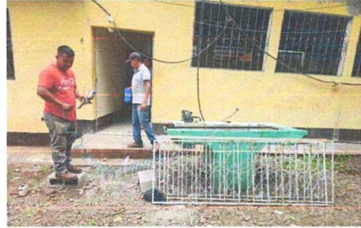
Foto 2: Mantenimiento a balcones, cepillado, lijado y aplicación de pintura anticorrosiva.
