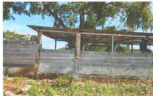
Foto 6: Mantenimiento a muro perimetral.
