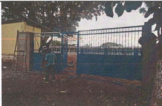
Foto 5: Suministro e instalación de portón de metal de 6m de largo por 2.5 m de alto.
