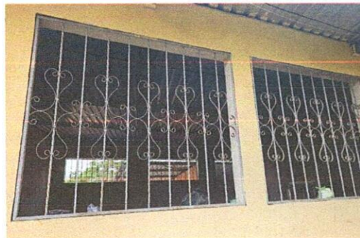
Foto 4: Suministro e instalación de ventanas de PVC
