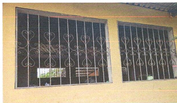
Foto 2: Mantenimiento a balcón de metal, lijado, cepillado y aplicación de pintura.
