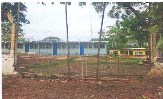
Foto 5: Suministro en instalación de portón metálico.
