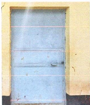
Foto 3: Mantenimiento a puerta de metal, lijado, cepillado y aplicación de pintura.
