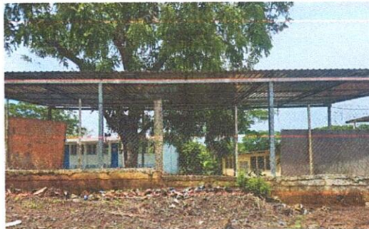
Foto 6: Mantenimiento a muro perimetral
