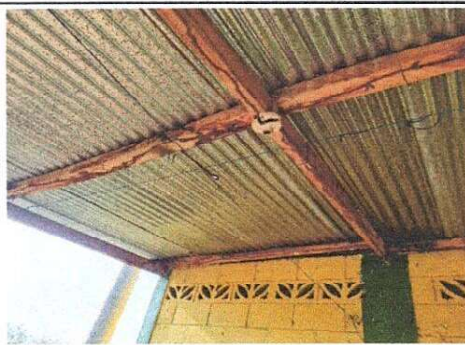
FOTO 4: Sustrucción de estructura por estructura de metal + sustitución de lámina por lámina troquelada aluzinc calibre 26
