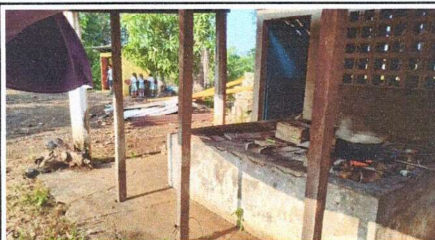
FOTO 2: Sustrucción de losa de patio t: 0.10
