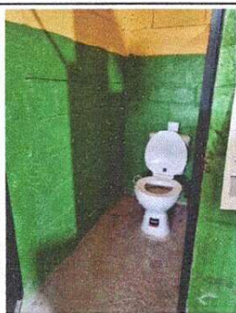
FOTO 3: Suministro de piso antideslizante + azulejo en paredes
