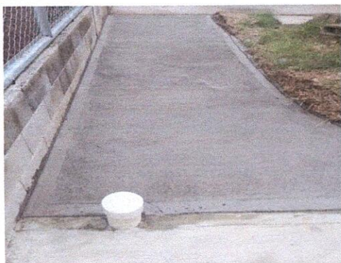
Foto 9: Suministro de Banqueta de 6 metros cuadrados
