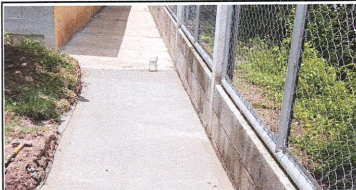
FOTO 8: Suministro de drenaje.
