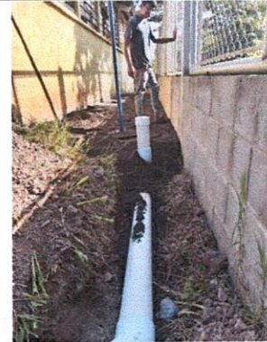
FOTO 8: Suministro de drenaje.
