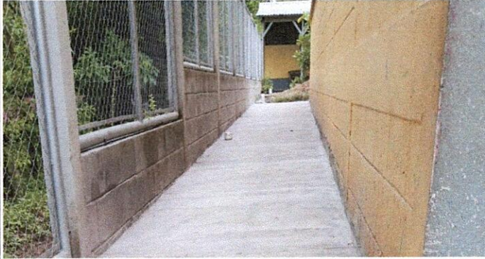
Foto 1: Suministro de Banqueta de concreto t: 0.10 (módulo de aulas)
