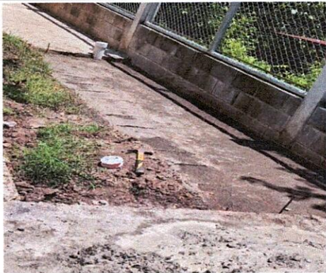
Foto 9: Suministro de banqueta de 6 metros cuadrados
