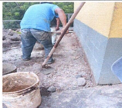
Foto 2: Suministro de banqueta de concreto t 0.10 (módulo de aulas)
