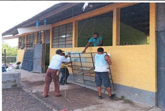
FOTO 3: Suministro de balcón de hierro 1/2", Mantenimiento d epuertas de metal de 1.00 x 2.00 (cepillado, lijado y aplicación de pintura).
