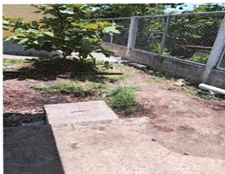
Foto 9: Suministro de banqueta de 6 metros cuadrados
