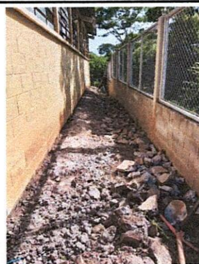
FOTO 8: Suministro de drenaje.
