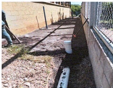
Foto 1: Suministro de banqueta de concreto t 0.10 (módulo de aulas)
