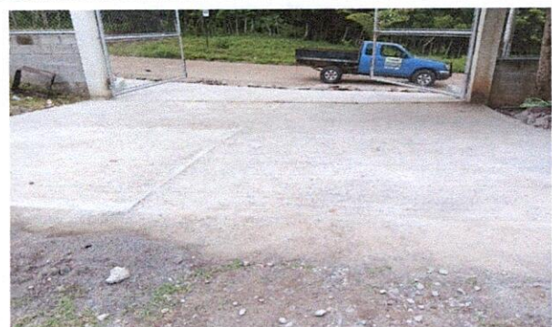
Foto 6: Suministro de banqueta de concreto t: 0.10 (área de ingreso)
