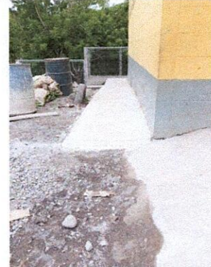
Foto 2: Suministro de Banqueta de concreto t: 0.10 (módulo de aula)
