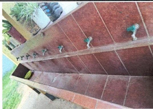
Foto 4: Sustitución de grifos de agua potable
