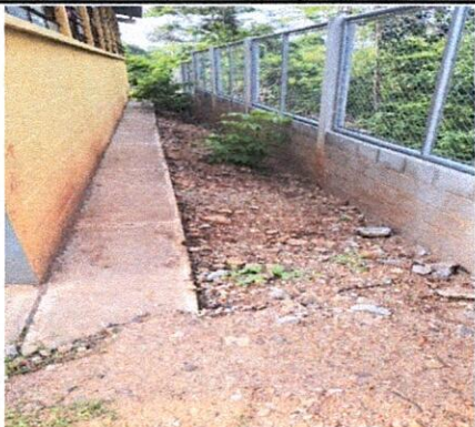
Foto 1: Suministro de banqueta de concreto t: 0.10 (área de ingreso, módulo de aulas)
