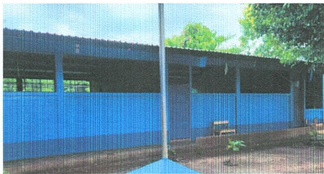
FOTO: Aplicación de pintura de aceite en paredes
