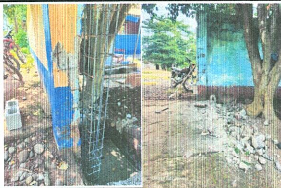
FOTO 4: Sustitución de portón de metal de 4.00 x 2.00
