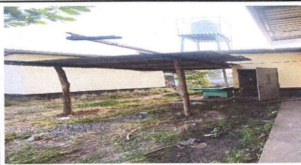
FOTO 4: Sustitución de estructura de techo de lámina + suministro de losa de patio t: 0.05
