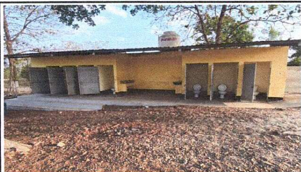
FOTO 1: Sustitución de inodoros en módulo de servicios sanitarios
