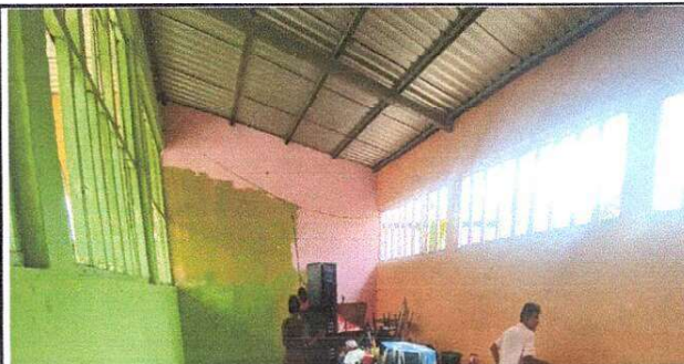
FOTO 6: Sustitución de balcones de metal
