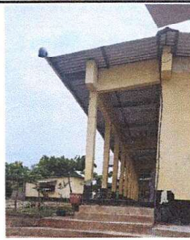
FOTO 2: Suministro de bajadas pluvial de 6"
