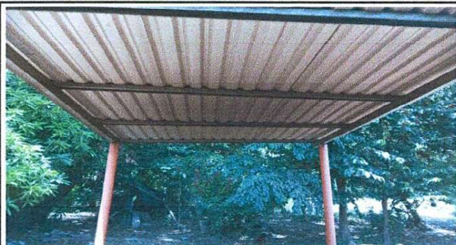
Foto 1: Sustrucción de cubierta de lámina y sustitución de estructura de soporte
