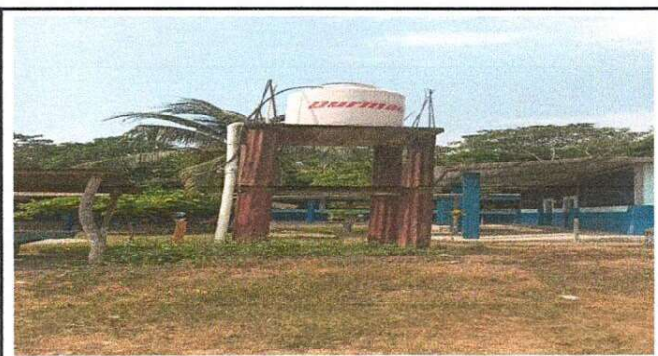
Foto 6: Sustrucción de torre de concreto por torre de concreto
