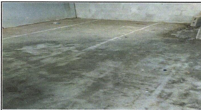
Foto 3: SUSTITUCIÓN DE PISO TORTA DE CONCRETO
