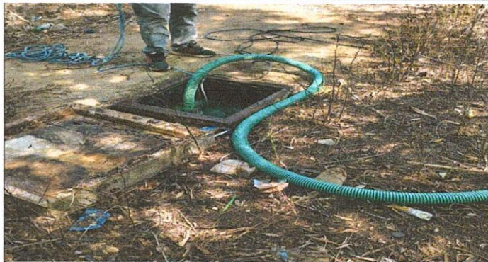
Foto 2: LIMPIEZA DE FOSA SEPTICA.
