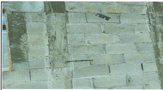
Foto 4: REPELLO EN PAREDES
