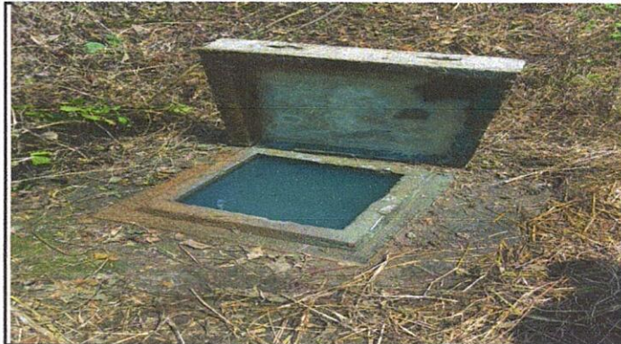
Foto 2: LIMPIEZA DE FOSA SEPTICA.
