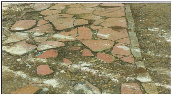
Foto 3: SUSTITUCIÓN DE PISO TORTA DE CONCRETO
