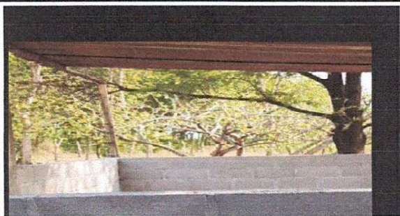
FOTO 1: SUMINISTRO DE PILA DE CONCRETO
