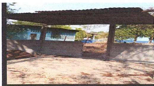
FOTO 5: SUMINISTRO DE COLUMNAS DE HORMIGON ARMADO DE 20*20
