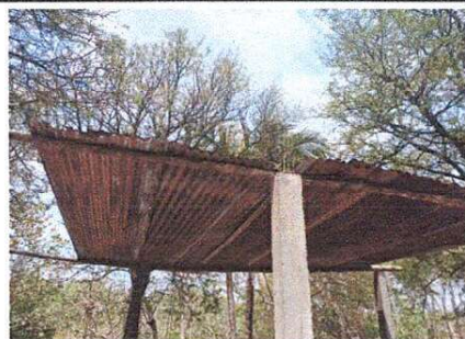
FOTO 6: SUMINISTRO DE CUBIERTA DE LAMINA TROQUELADA
