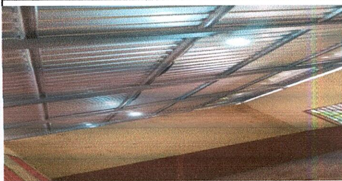
FOTO 3: SUMINISTRO DE ESTRUCTURA PORTANTE DE METAL.
