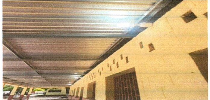
FOTO 2: SUSTITUCIÓN DE LÁMINAS TROQUELADA ALUZINC CALIBRE 26, SUMINISTRO DE ESTRUCTURA PORTANTE DE METAL.
