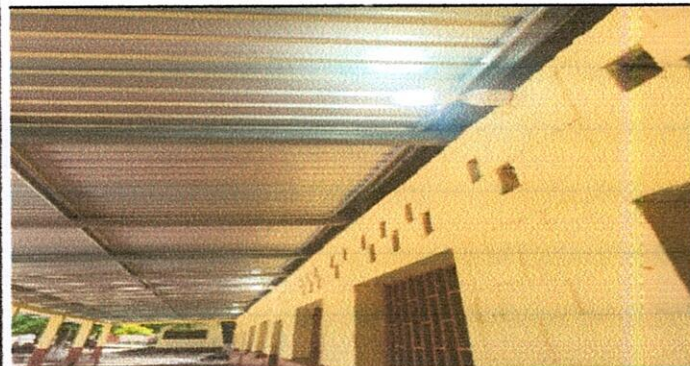
FOTO 5: SUSTITUCIÓN DE LÁMINA, POR LÁMINA TROQUELADA ALUZINC CALIBRE 26, SUMINISTRO DE ESTRUCTURA PORTANTE DE METAL.
