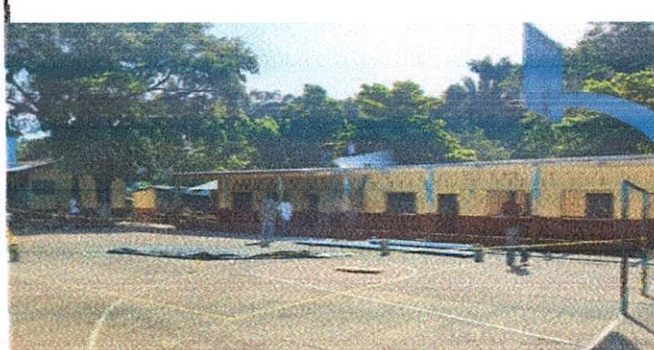
FOT 2: SUSTITUCIÓN DE LAMINAS, POR LAMINAS TROQUELADAS ALUZINC CALIBRE 26, SUMINISTRO DE ESTRUCTURA PORTANTE DE METAL
