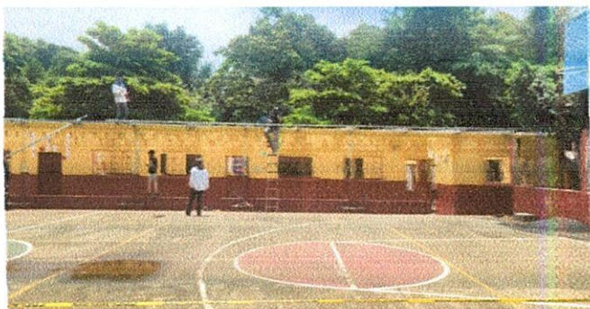
FOTO 1: SUSTITUCIÓN DE LAMINAS, POR LAMINAS TROQUELADAS ALUZINC CALIBRE 26
