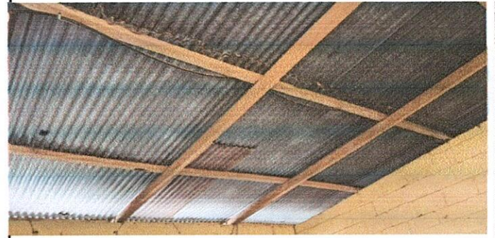
FOTO 4: SUSTITUCIÓN DE LÁMINAS, POR LAMINAS TROQUELADAS ALUZINC CALIBRE 26, SUMINISTRO DE ESTRUCTURA PORTANTE DE METAL.
