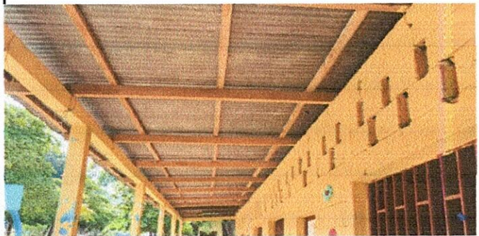
suministro de estructura portante de metal
