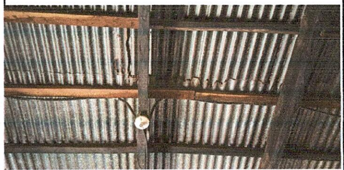
FOTO 2: SUSTITUCIÓN DE LÁMINAS, POR LÁMINA TROQUELADA ALUZINC CALIBRE 26, SUMINISTRO DE ESTRUCTURA PORTANTE DE METAL
