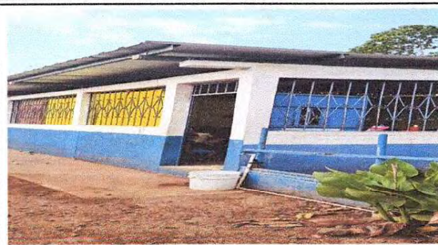
Foto 8: Suministro de cielo falso en estructura de techo de aula y sustitución de piso de torta de concreto por piso cerámico antideslizante
