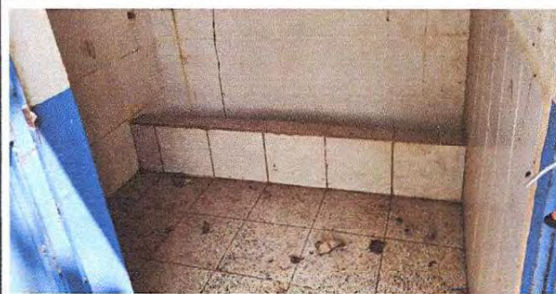
Foto 2: Sustitución de azulejo en mingitorio y reparación de drenajes
