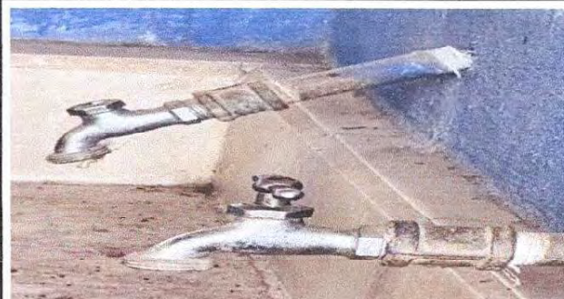
Foto 4: Sustitución de llaves de chorro
