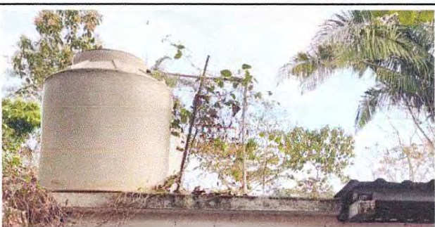
Foto 5: Suministro de base de block y sustitución de depósito de polietileno de 2,500 litros
