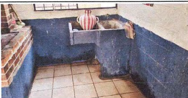
Foto 11: Sustitución de pila incluye la reparación del drenaje
