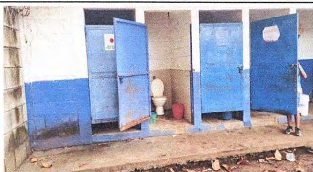
Foto 1: Reparación de servicios sanitarios y sus accesorios
