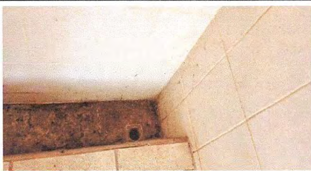
Foto 7: Reparación del drenaje del mingitorio
