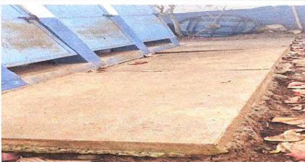
Foto 3: Sustitución de banqueta de concreto en servicios sanitarios
