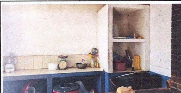
Foto 12: Suministro de puertas de PVC para gabinete de concreto
