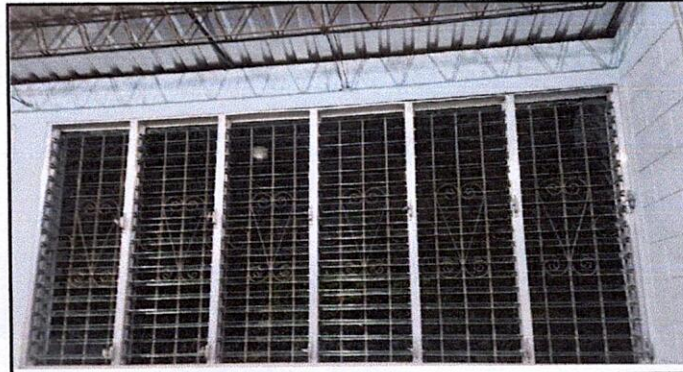
FINALIZACIÓN DE VENTANAS DE ALUMINO CON PALETA DE METAL
