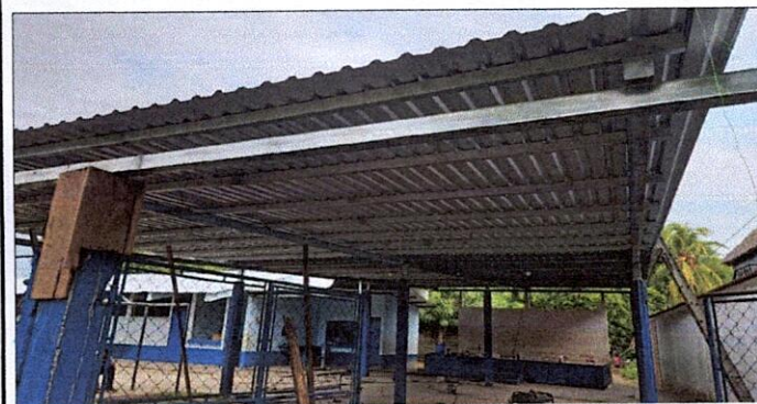
agregado de galera terminado
