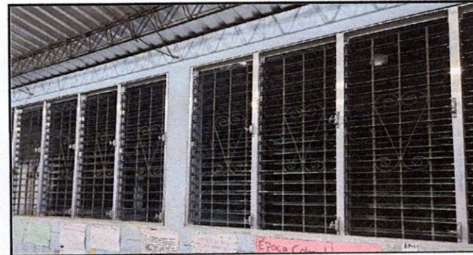
terminación de balcones de metal con ventana de vidrio transparente
