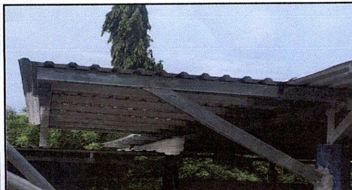
AGREGADO DE DOS LAMINAS LATERALES A UN COSTADO DE LA GALERA DEL ESCENARIO
