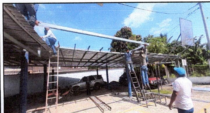
TERMINANDO DE COLOCAR AL ESTRUCTURA DEL AGREGADO DEL ESCENARIO
