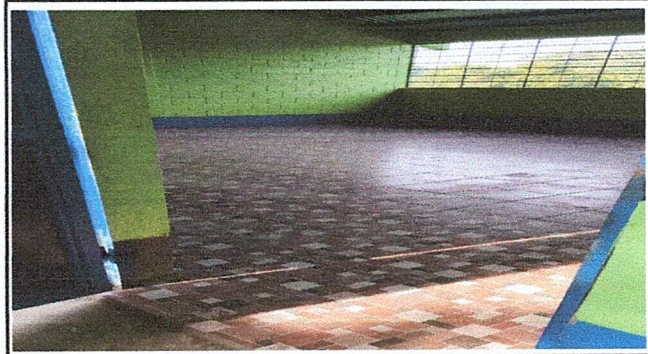
Foto 2: piso ceramico antideslizante modulo 2
