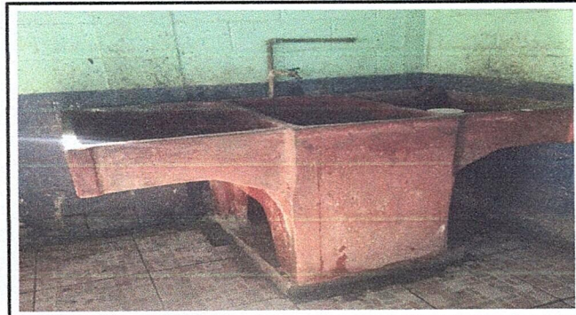
Foto 4: pila con drenaje y tubería de pvc 3"
