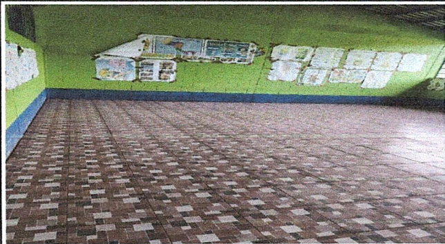
Foto1: piso ceramico antideslizante modulo 2
