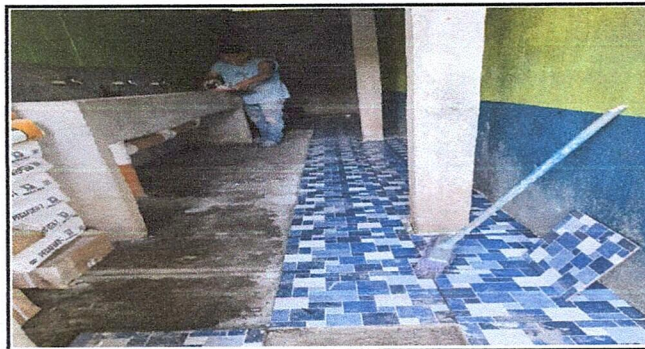
Foto 6: Se observa la necesidad de poner piso ceramico antideslizante en area de chorros
