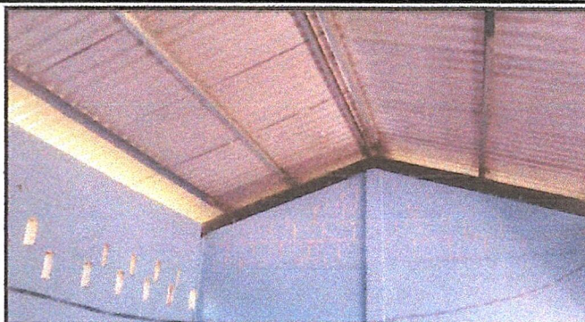
Foto 2: Reparación de techo y levantamiento de lámina
