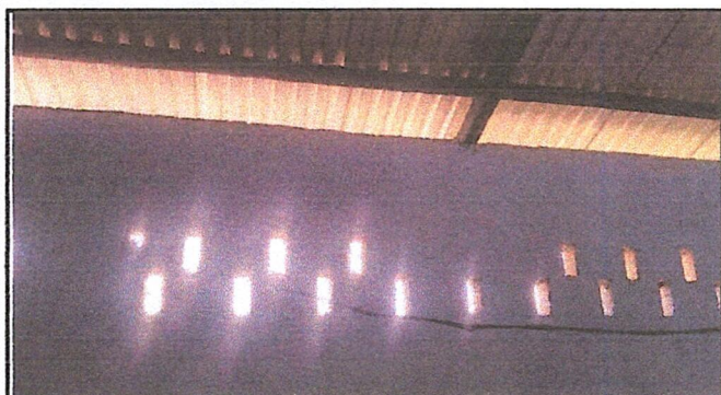
Foto 3: Iluminación de aula
