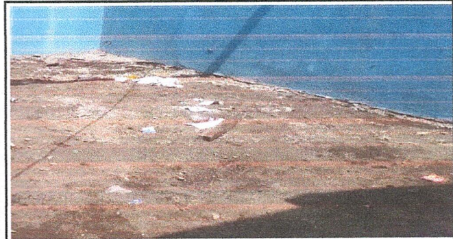
Foto 4: Banqueta de corredor
