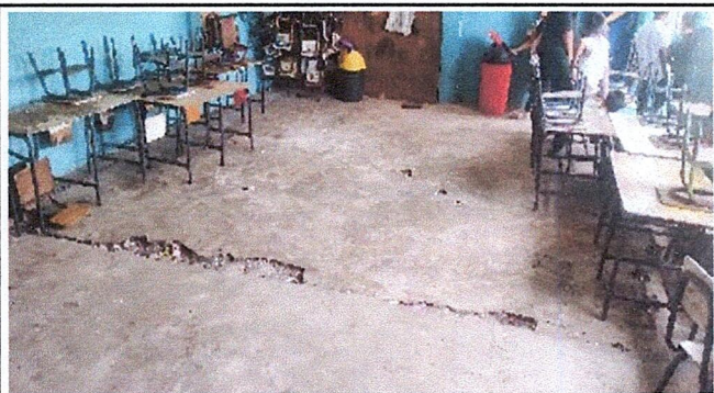
Foto1: Reparación de aulas
