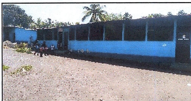
Foto 5: Banqueta y techado de salones de clases, ingresa el agua en invierno.
