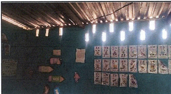
Foto 3: Iluminación de aula apertura de ventana y puerta
