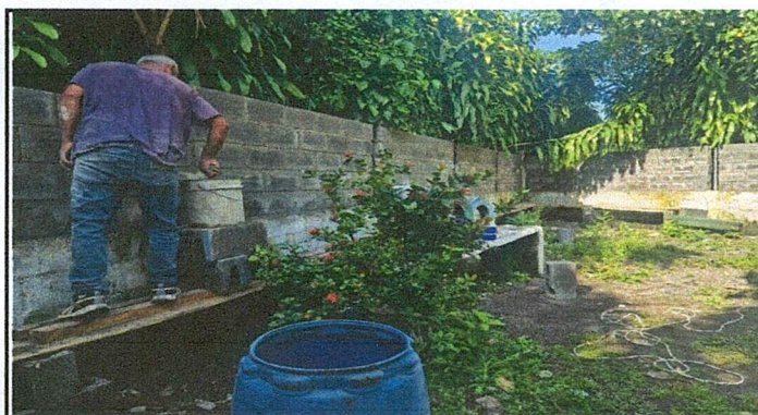
Foto 3: Suministro de block para circulación de muro perimetral
