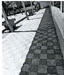
Foto 2: Sustrucción de piso de granito por piso de cerámico
