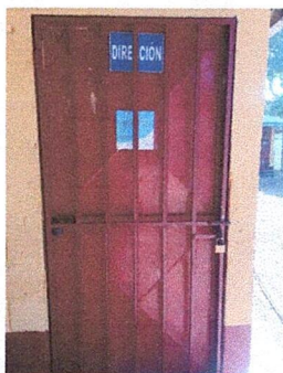
Foto 3: Suministro e instalación de contra puerta de metal
