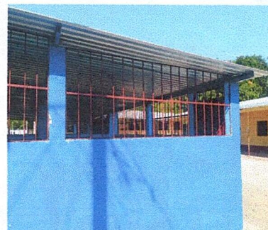
Foto 4: Suministro de block para muro (incluye columnas de 0.15 x 0.15 x 1.00 mts con hierro Ø 1/2" est. 1/4 + solera de 0.20 x 0.15 con hierro Ø 3/8" est. 1/4")
