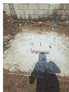
Foto 6: Realización de Suministro de fosa séptica, 1 metro a la redonda x 6 metros de profundidad
