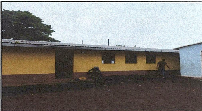
Foto 1: Sustrucción de tubería por tubería PVC Ø 4" (incluye zanjeo, compactación, colocación de tubería y relleno)
