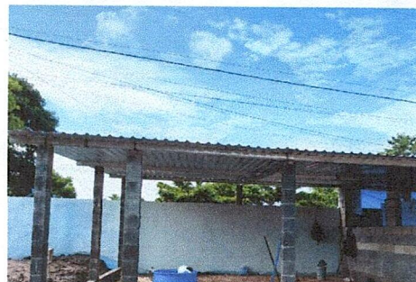
Foto 4: Suministro de block para muro (incluye columnas de 0.15 x 0.15 x 1.00 mts con hierro Ø 1/2" est. 1/4 + solera de 0.20 x 0.15 con hierro Ø 3/8" est. 1/4")
