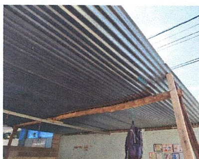
Foto 5: Sustrucción de costanera de madera por costanera metálica 2 x 3, Sustrucción de lámina por lámina troquelada cal. 26
