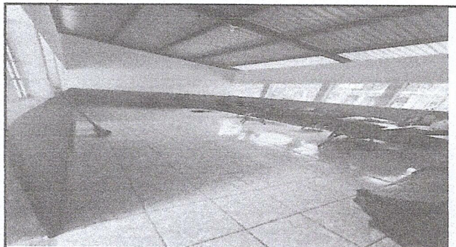
Foto 3: UNA DE LAS AULAS CON CAMBIO DE PISO DE CEMENTO POR CERAMICO DEL MODULO 1 SU TOTALIDAD.
