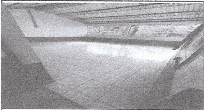
UNA DE LAS AULAS CON CAMBIO DE PISO POR CERAMICO DEL MODULO 2 SU TOTALIDAD.
