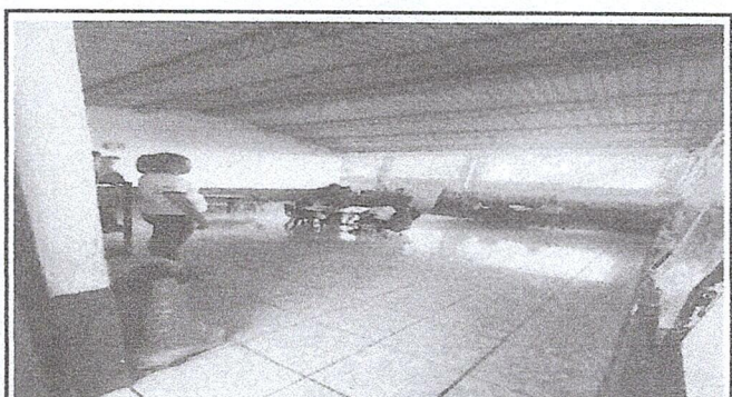
Foto 4: UNA DE LAS AULAS CON CAMBIO DE PISO POR CERAMICO DEL MODULO 2 SU TOTALIDAD.
