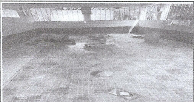
Foto 4: INSTALACION DE PISO EN AULA DE MODULO 1
