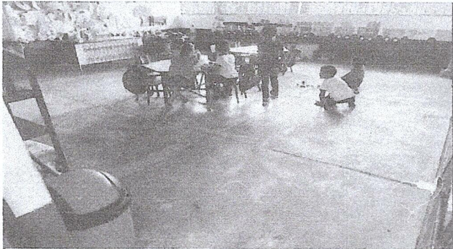
Foto1: Se realizara la sustitución de piso rustico por piso ceramico en modulos de aulas
