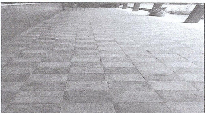
Foto 4: Se realizara la sustitución de piso de cemento liquido por piso ceramico en modulos de aulas y pasillo
