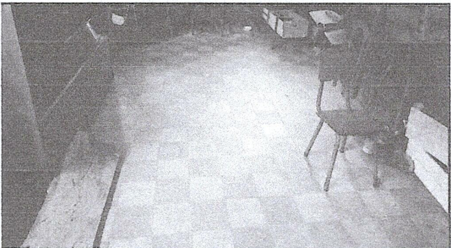
Foto 2: Se realizara la sustitución de piso de cemento liquido por piso ceramico en modulos de aulas
