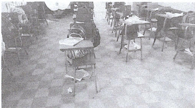
Foto 3: Se realizara la sustitución de piso de cemento liquido por piso ceramico en modulos de aulas
