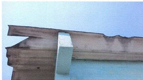
Foto 2: Sustitución de cubieta de lamina duralita a lamina trocuela aluzinc.
