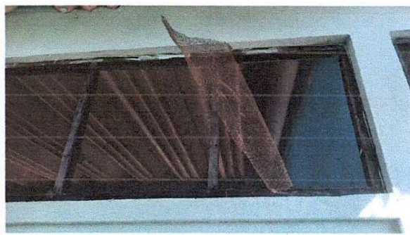
Foto 4: Sustitucion de ventanas de madera por balcon.
