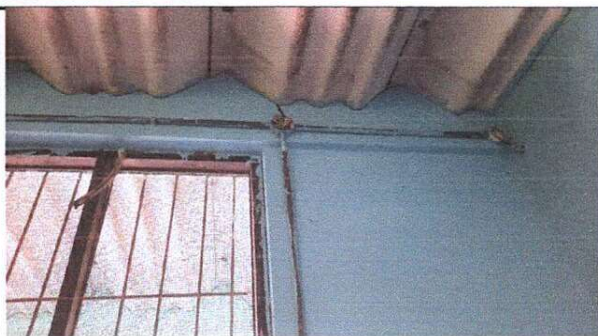
Foto 5: reparacion de sistema electrictrico
