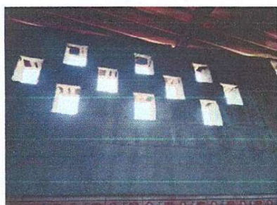
Foto 5: APERTURA DE MURO PARA VANO DE BALCON
