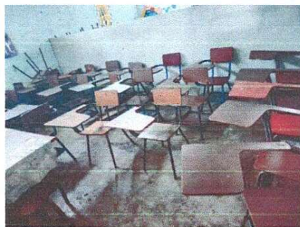
Foto 2: SUSTITUCIÓN DE EPISO POR PISO CERAMICO ANTIDESLIZANTE EN AULA 1-2
