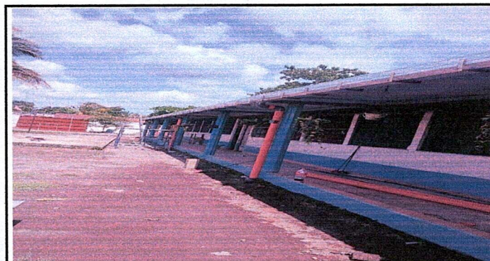
Foto 4: instalacion de canales de metal + bajadas de agua pluvial
