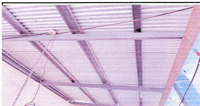
Foto 3: Sustitucion de vigas de madera por estructura de metal
