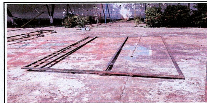
Foto 6: Sustitución de porton de 3.30X2.45 mts
