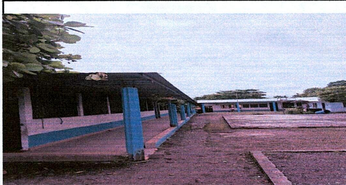
Foto 4: instalacion de canales de metal + bajadas de agua pluvial
