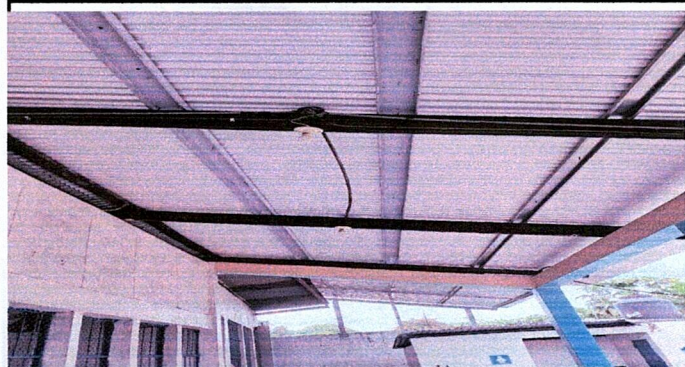
Foto 3: Sustitucion de vigas de madera por estructura de metal
