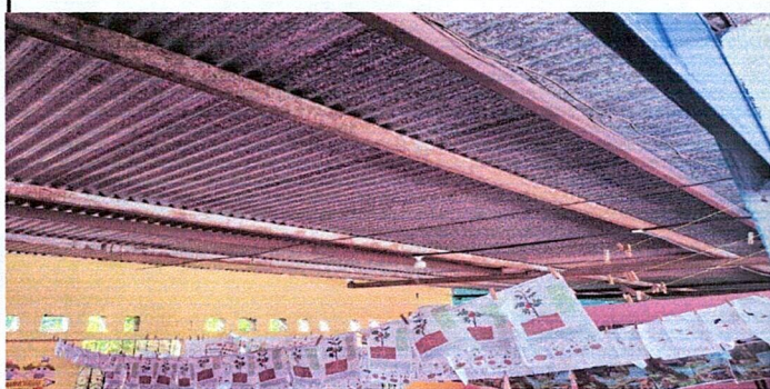
Foto1: Mantenimiento a estructura de metal (lijado cepillado + aplicación de pintura azul anticorrosiva)
