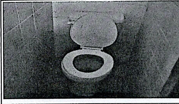
Foto 4: Sustitución de inodoros en servicio sanitarios
