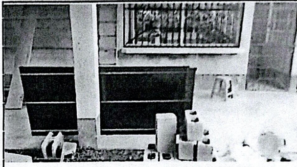
Foto 2: Se instalara el suministro de puertas de metal de 2.10X1.00 mts
