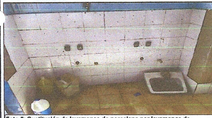
Foto 5: Sustitución de lavamanos de porcelana por lavamanos de concreto más revestimiento de azulejos en servicios sanitrios
