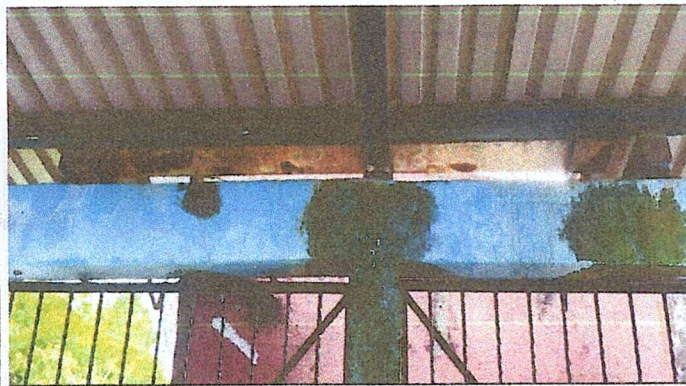
Foto 3: Se realizara la sustitución de canal de metal existente por canal de metal fabricado de 0.30X0.20 mts + instalación de bajadas de agua pluvial
