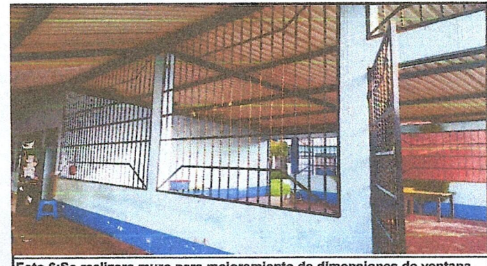
Foto 6: Se realizara muro para mejoramiento de dimensiones de ventana sustitución de balcones de metal por muro de block para reducción de dimensiones de ventanas
