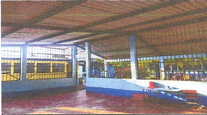
Foto1: Se realizara la instalación de ventanas PVC area de cocina
