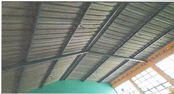
Foto 7: Mantenimiento de estructura metalica 272 metros, modulo 2 consta 5 aulas (Incluye cepilladon, lijado y apliacion de pintura )
