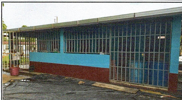
Foto1: Instalación 8 metros lineales de canal de metal y bajada de agua pvc en area de sanitarios
