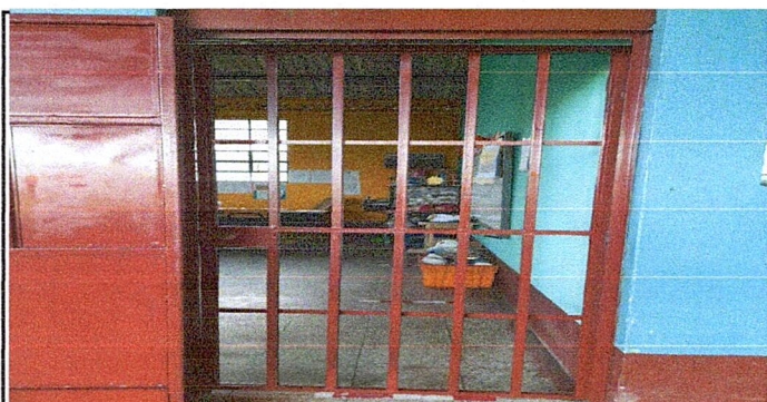
Foto 6: 2 metros de mantenimiento lijado, cepillado y aplicación pintura de balcon en area de dirección
