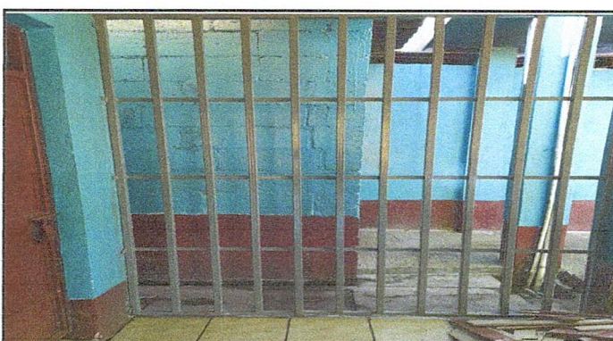
Foto 10: Mantenimiento y reparación de reja de metal en servicios sanitarios 3 metros
