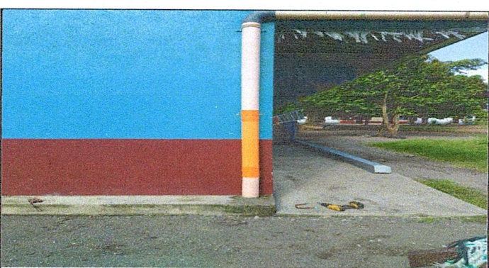
Foto 6: Sustitución de bajada de agua plubial tubo pvc en modulo 2
