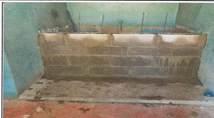
Foto 2: Sustitución de pila de cemento, por pila fundida de un lavadero azulejado 1.50 X1.00 metros
