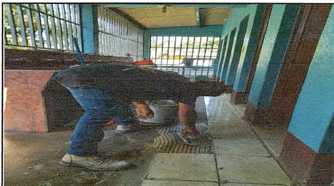
Foto 8: Sustitución de piso de cemento por piso ceramico en servicios sanitarios 27 metros
