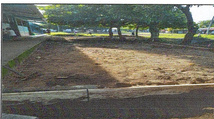
Foto 4: Reparación de losa 171 metros
