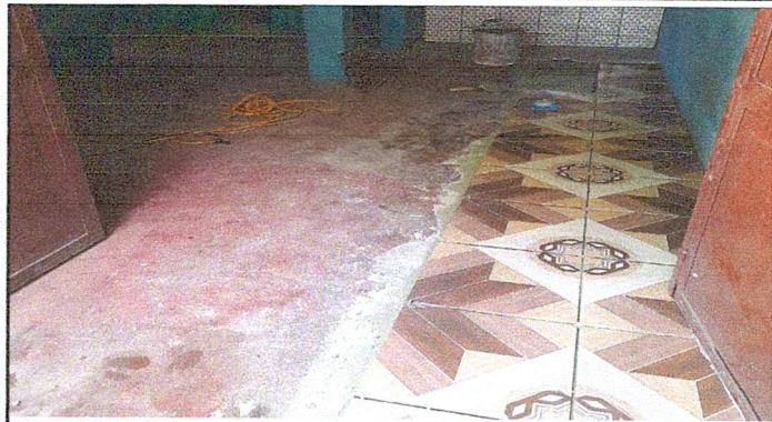
Foto1: Sustitución de piso de cemento por piso ceramico en cocina 20 metros
