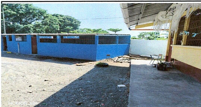
Foto 2: Suministro de block para circulación de muro (incluye columnas de 0.15 x 0.15 x 1.00 mts con hierro Ø 1/2" est. 1/4 + solera de 0.20 x 0.15 con hierro Ø 3/8" est. 1/4") (modulo de aula)
