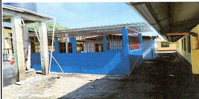
Foto 4: Sustitución de costanera de madera por costanera metálica 2 x 3. Sustitución de lámina por lámina troquelada cal. 26
