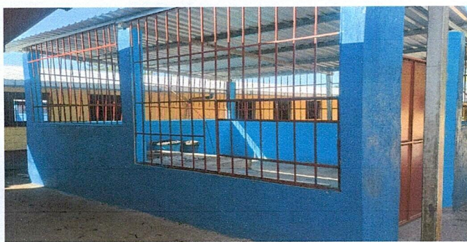
Foto 5: suministro e instalacion de balcon metalico con marco de angular 1x1 reforzado con hierro 3/8 area cocina
