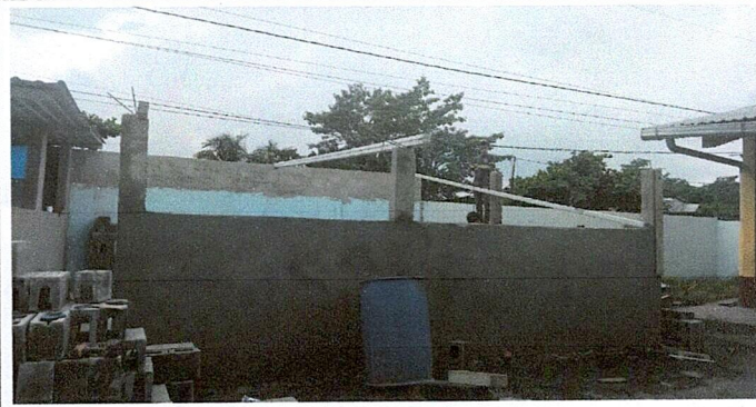
Foto 2: Suministro de block para circulación de muro (incluye columnas de 0.15 x 0.15 x 1.00 mts con hierro Ø 1/2" est. 1/4 + solera de 0.20 x 0.15 con hierro Ø 3/8" est. 1/4") (modulo de aula)
