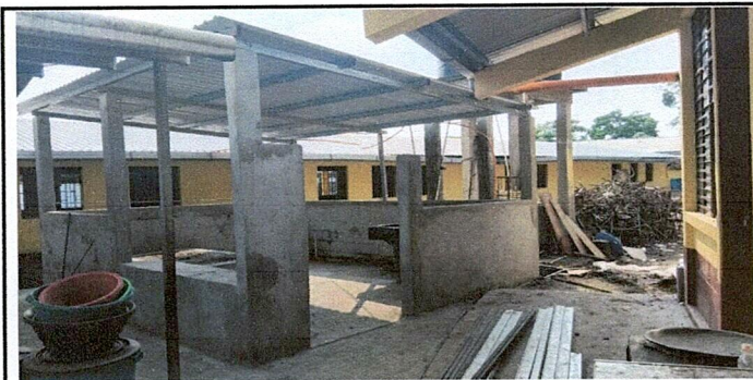
Foto 5: sustitucion de lamina , por lamina troquelada , area de cocina
