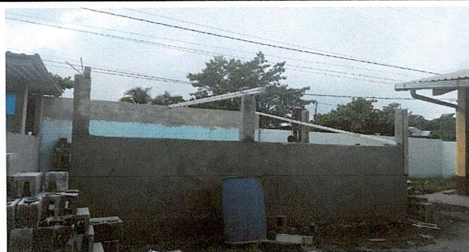
Foto1: sustitucion de coscandra de madera por costanera metalica 2x3. sustitucion de lamina por lamina troquelada cal 26 (modulo de aula)
