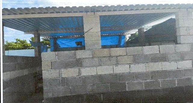
Foto 3: suministro de repello . Modulo aula. Suministro e instalación de balcón metálico con marco de angular 1" x 1" reforzado con hierro 3/8" (incluye pago de mano de obra)
