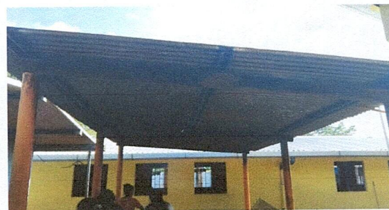
Foto 4: Sustitución de costanera de madera por costanera metálica 2 x 3. Sustitución de lámina por lámina troquelada cal. 26
