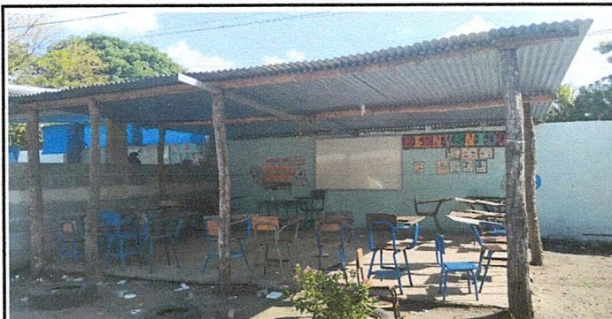
Foto1: sustitucion de coscandra de madera por costanera metalica 2x3. sustitucion de lamina por lamina troquelada cal 26 (modulo de aula)
