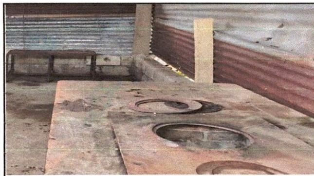
Foto 4: Sustitución de estufa rural más mueble de concreto y gavinete aereo
