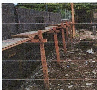
3. Suministro de block para circulación de muro perimetral (incluye columnas de 0.15 x 0.15 x 1.00 mt con hierro Ø 1/2" est. 1/4 + solera de 0.20 x 0.15 con hierro Ø 3/8" est. 1/4")
