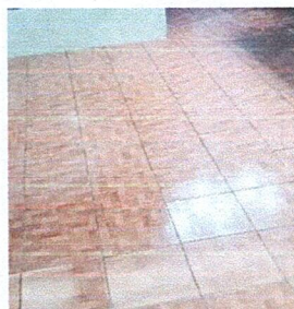
2. Sustitución de piso de granito por piso ceramico
