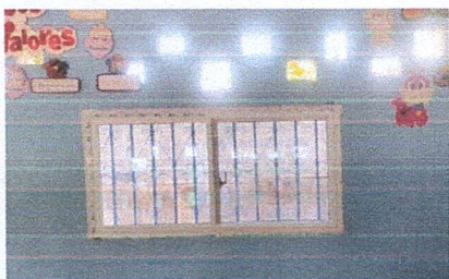
5. Suministro e instalación de ventana U-pvc
